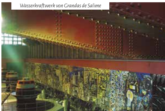
Wasserkraftwerk von Grandas de Salime
