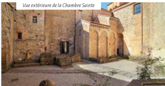
Vue extérieure de la Chambre Sainte
