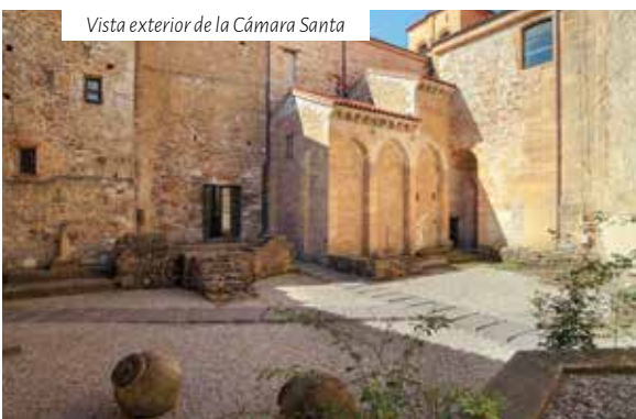
Vista exterior de la Cámara Santa
